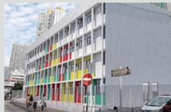
南昌街項目首個以組裝成建築技術建成的過渡性房屋項目。項目為一棟四層高，附設開放式廚房的組合屋，提供89個單位，約150人受惠，預期今年第二季推出。
