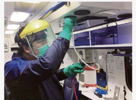
機電工程署採用專門技術消毒救護車的空調系統。
